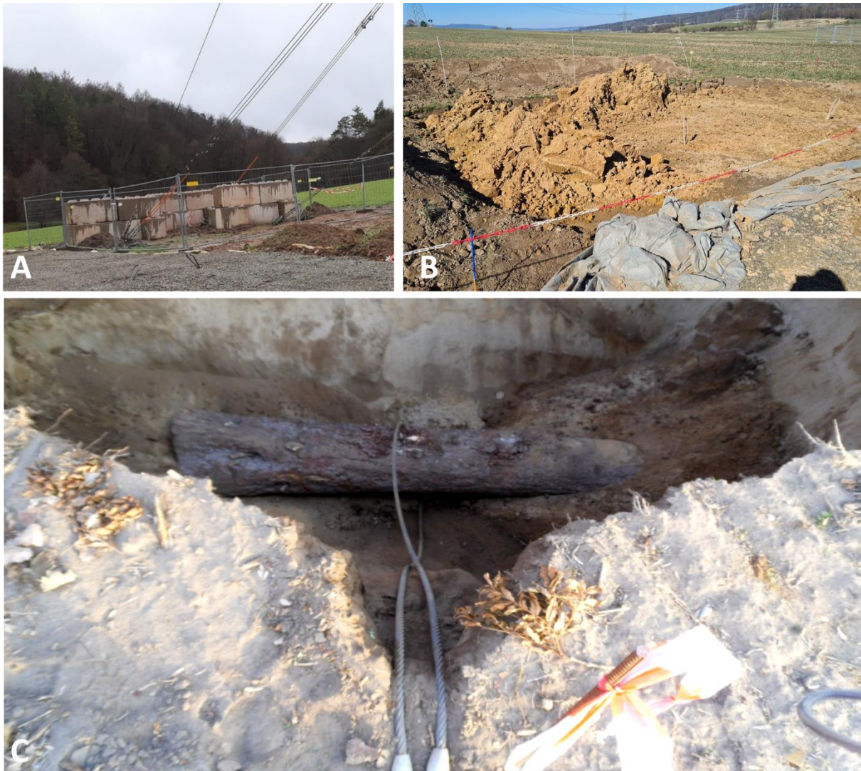
Abbildung 5: Zwei verbreitete Varianten um Masten während des Seilzuges abzuankern: A) Auflastanker B) ein sogenannter Totmannanker eingebaut C) ein sogenannter Totmannanker während des Einbaus (Blick in die Baugrube)
