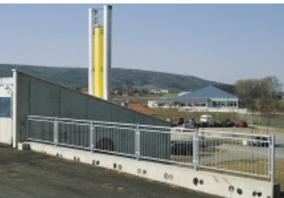
Heizwerk mit Schwimmbad
