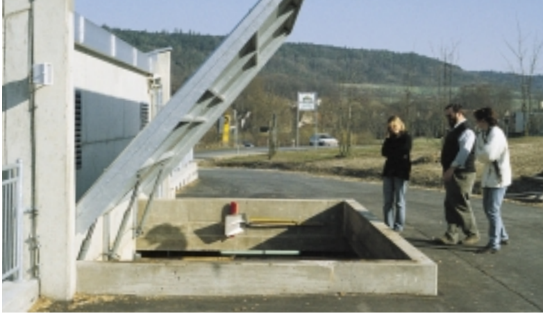
Besichtigung des geöffneten Brennstoffbunkers
