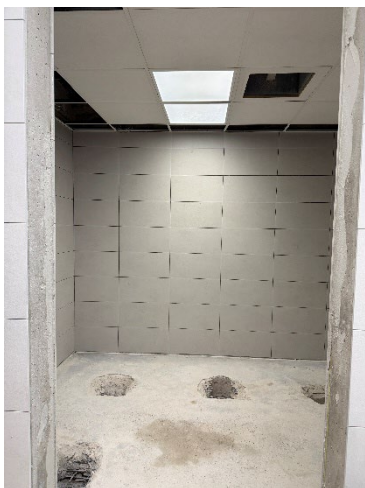
Bildunterschrift: Neue Fliesen für Wände und Böden. Die Abflüsse müssen ebenfalls erneuert werden.
