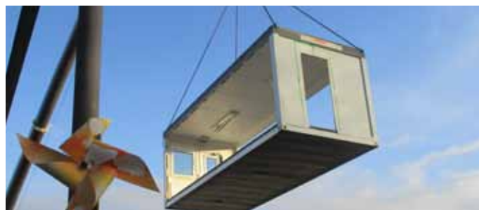
Die Container wurde entfernt
