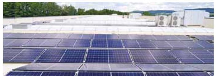
Nachhaltig und energieunabhängig: Rund 13.000 m<sup>2</sup> zusätzliche Dachflächen auf den Hallen P3 und P4 sind mit einer rund 1.100 kWp großen PV-Anlage ausgestattet.
