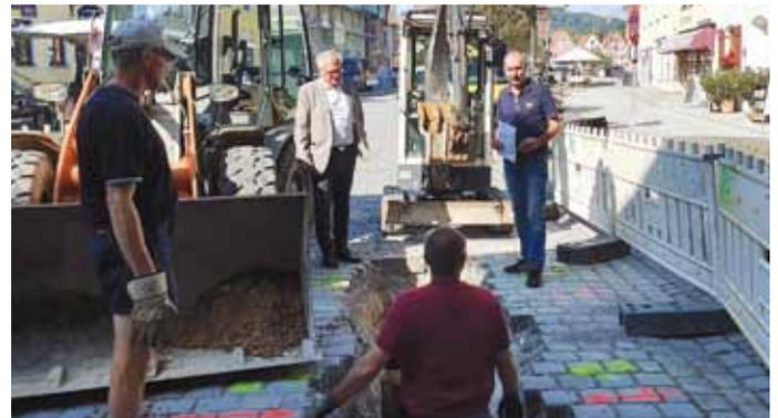
Verlegung der neuen Wasserleitung sowie der Fernwärmeleitung. Im Anschluss sollen die umfassenden Pflasterarbeiten und die Neugestaltung des Pettenkoferplatzes gemeinsam mit der Firma Englmann begonnen werden.
