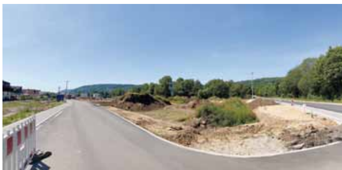
Erschließungsarbeiten für Baugebiet südlich der Südtangente werden abgeschlossen
