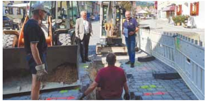
Pettenkoferplatz erhält neue Wasserleitung
