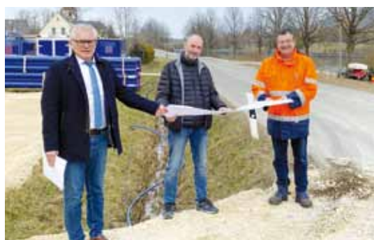
Bau der neuen Wasserleitung zwischen Berching und Eglasmühle
