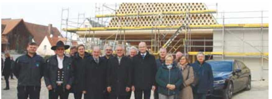
Meilenstein auf der Baustelle - Richtfest der Kulturhalle
