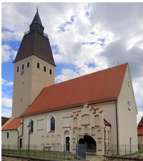
Ehemalige Pfarrkirche St. Lorenz (1062-1519)
