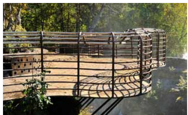
Ausgucke und Picknickbereiche (Bsp. Scenic Routes, Norwegen)
