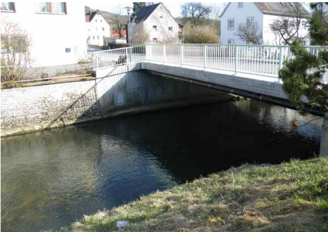
Sulzbrücke an der Schlesierstraße
