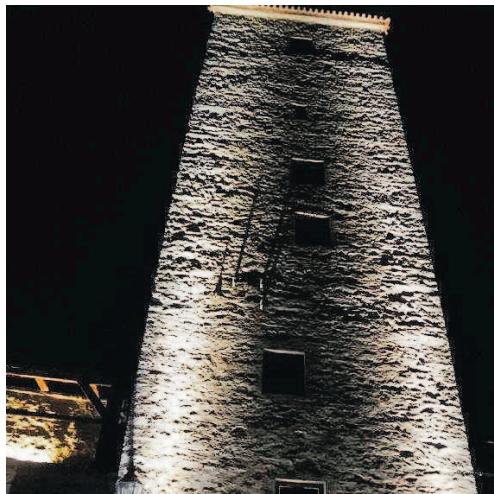
Besondere Illuminationen ließen diverse Bauwerke in wörtlich „ganz neuem Licht“ erscheinen.
